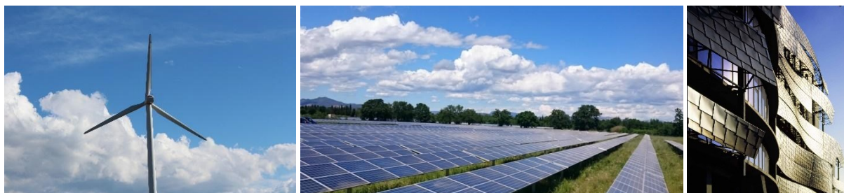
Éolienne à Rivesaltes ; Centrale solaire sur trackers du Soler ; UTVE de Calce – Sources : AURCA ; La Semaine du Roussillon ; Sydetom66
