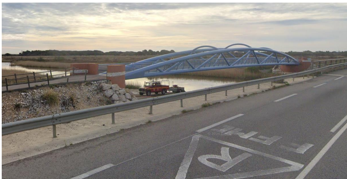
Figure 18 : Passerelle cyclable au-dessus du Bourdigou et longeant la RD81 à Torreilles (Google Maps, 2023).
