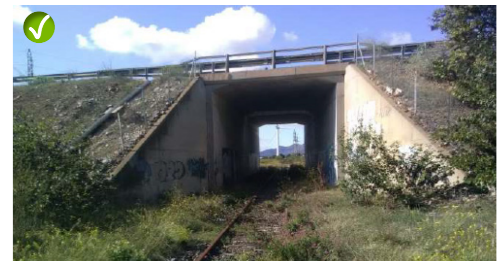
Pont cadre sous l'A9 à Rivesaltes. Ecotone®
