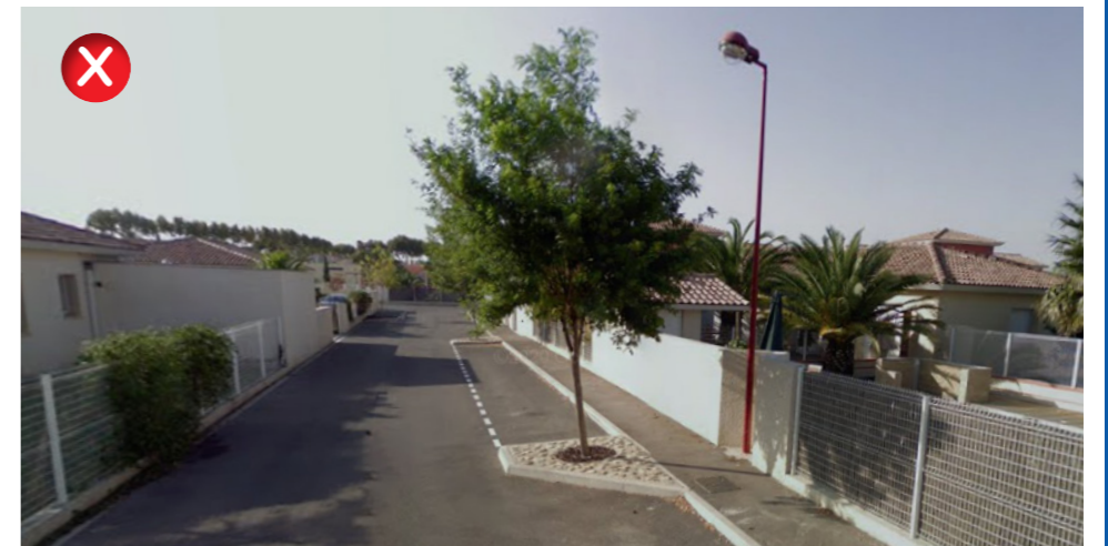
Bordure droite T1 infranchissable, entravant le chemin de l'eau vers le pied d'arbre à Saint-Estève
