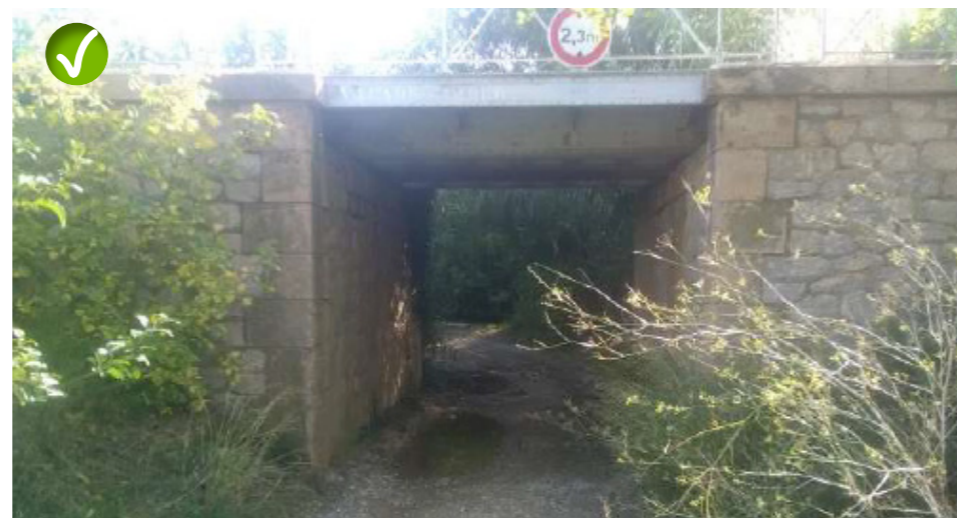
Pont cadre sous TPCF à Rivesaltes. Ecotone®
