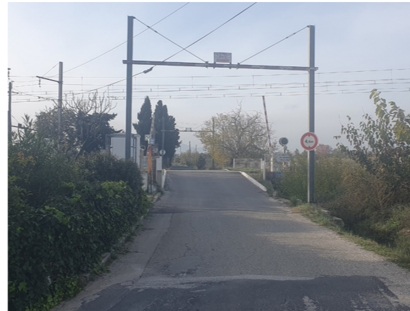
Chemin du Mas Palegry (Perpignan) : le passage à niveau se trouve à proximité de Tecnosud 2 dont l'accès routier depuis la RD914 est saturé. L'adaptation de l'accès actuel à Tecnosud 2 est programmée dans le cadre de la requalification de la Rocade Sud (AURCA, 2024).
