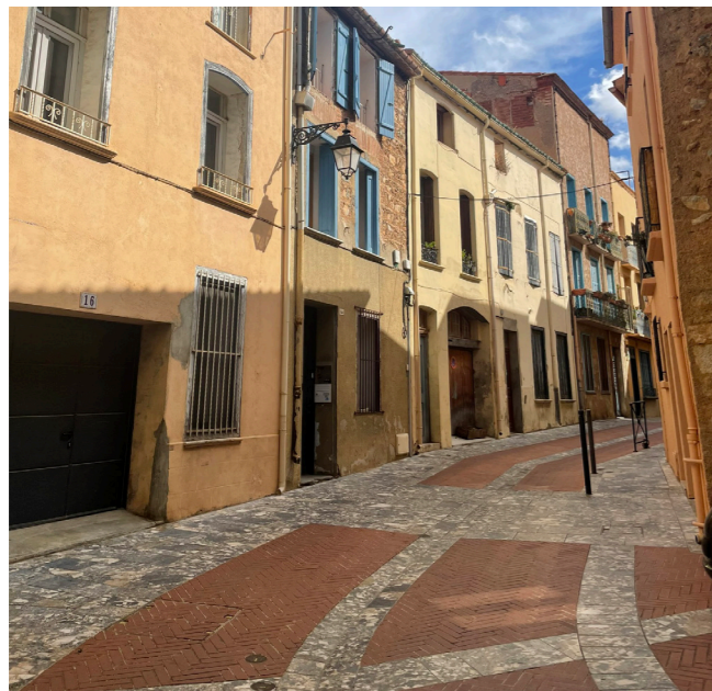
Centre ancien (Baixas) : Zone de rencontre (AURCA, 2024).
