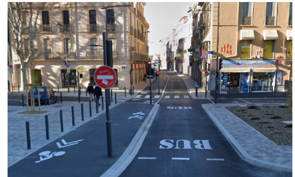
Rue Jean Payra (Perpignan) : voie support de partage modal composée d'une voie réservée aux bus, d'une piste cyclable bidirectionnelle et de deux trottoirs (Google Maps, 2023).
