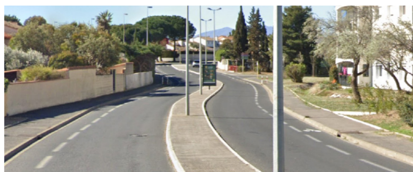
Avenue du Maréchal Leclerc (Cabestany) : voie de liaison interurbaine principale à double sens avec bande cyclable et trottoir de chaque côté (Google Maps, 2023)
