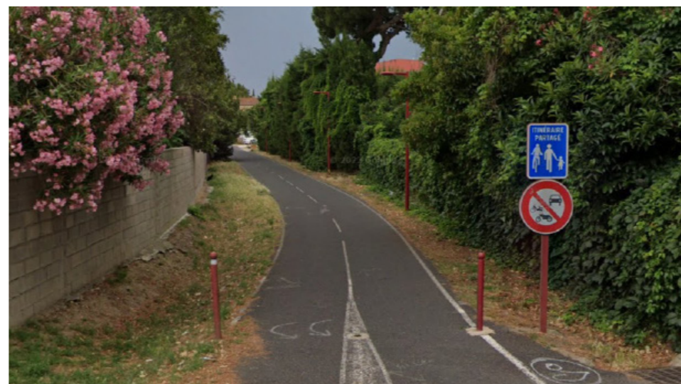
Chemin du Calvaire (Toulouges) : voie réservée aux cyclistes et aux piétons allant de Thuir à Perpignan sur le tracé d'une ancienne voie ferrée et traitée comme une voie verte. Sur la photo de droite, la continuité cyclable au niveau de l'intersection est marquée par la signalisation horizontale (Google Maps, 2022).
