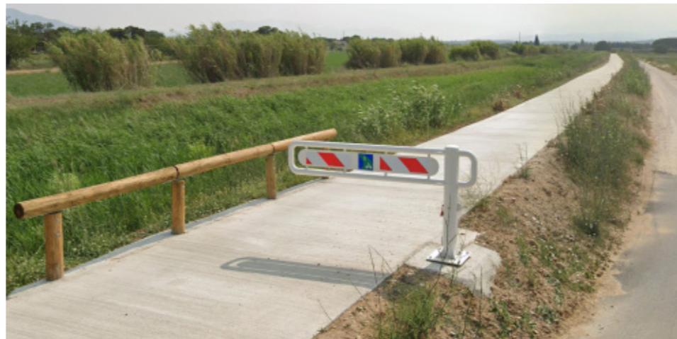
Voie verte de l'Agouille de la Mar (Montescot) : barrière en métal (Google Maps, 2023).
