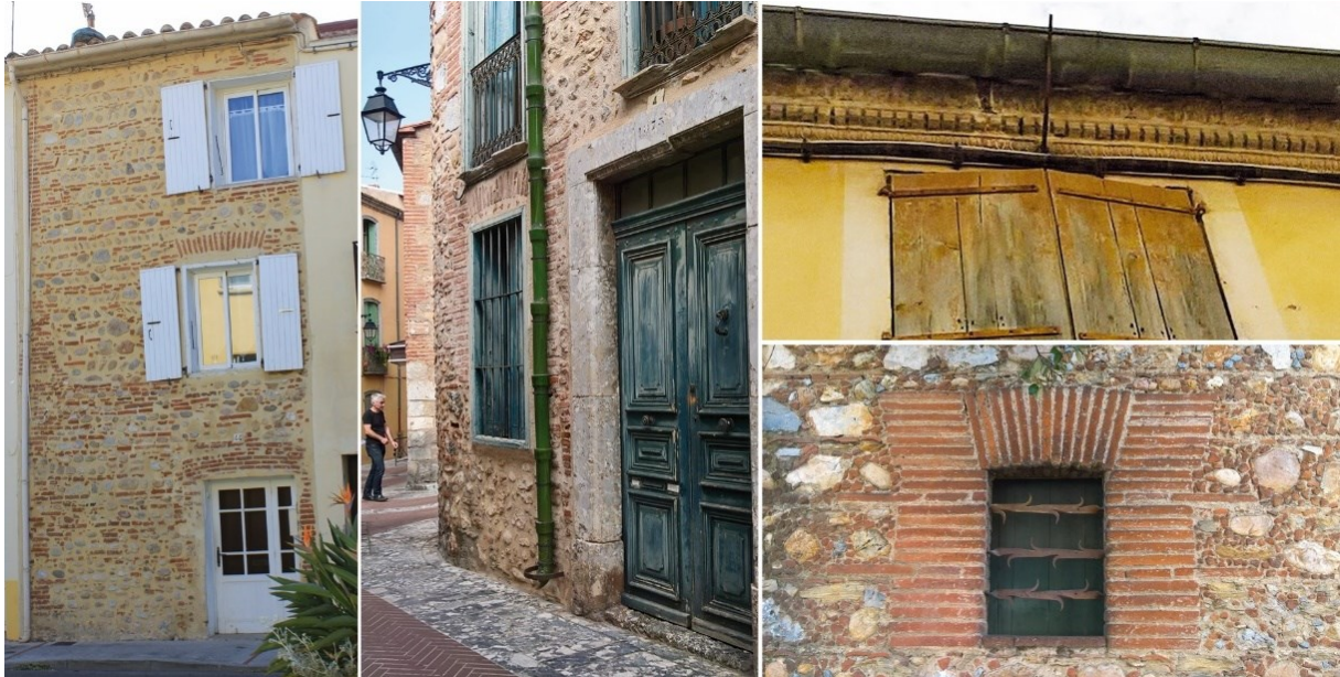
Maison de ville à Saint-Estève / Descente pluviale en terre cuite vernissée couleur verte, Baixas / Génoise décorée (moulure), Baixas / Détail du mur en pierre de rivière et cayrou, Baixas
