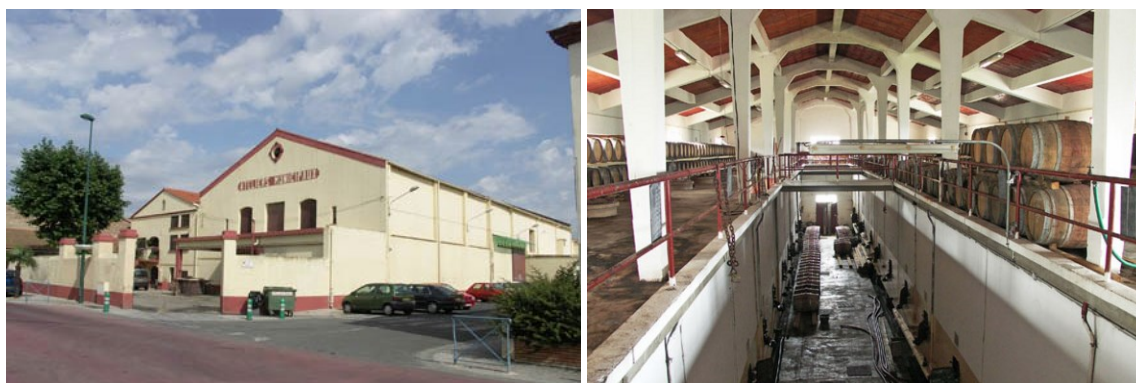
De gauche à droite : cave coopérative de Bompas et structure en béton armé de la cave de Montner
