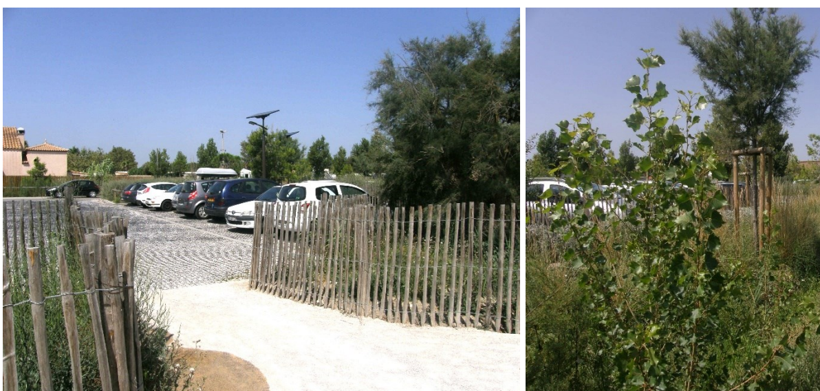
Stationnement perméable, végétalisé et avec candélabres solaires
