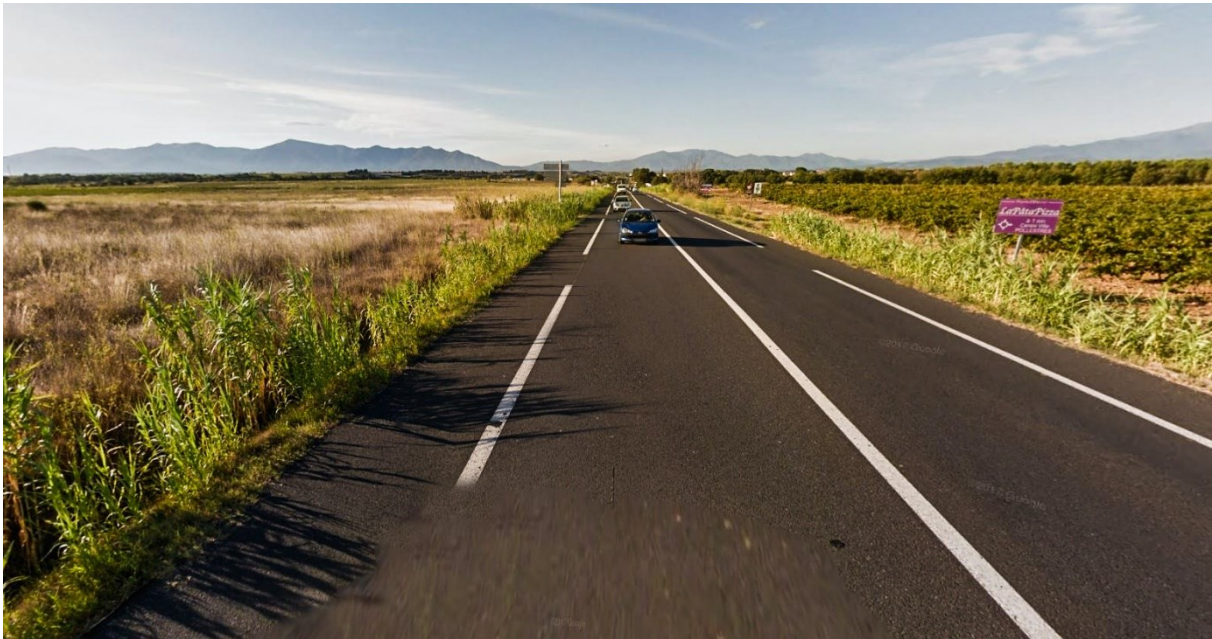
RD900 : voie de liaison interurbaine permettant l'appréciation du grand paysage, en dégagant une vue sur le massif des Albères
