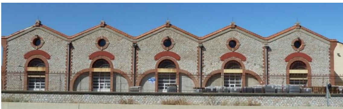
Ancienne cave coopérative Byrrh à Rivesaltes (labélisée patrimoine du XXème siècle)
