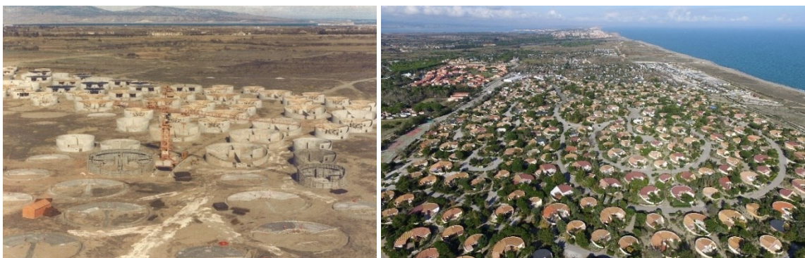
Le village des sables en construction à gauche / A droite : le village conquis par la végétation dunaire (Source : torreillesvacances.free.fr/histoire_VdS )
