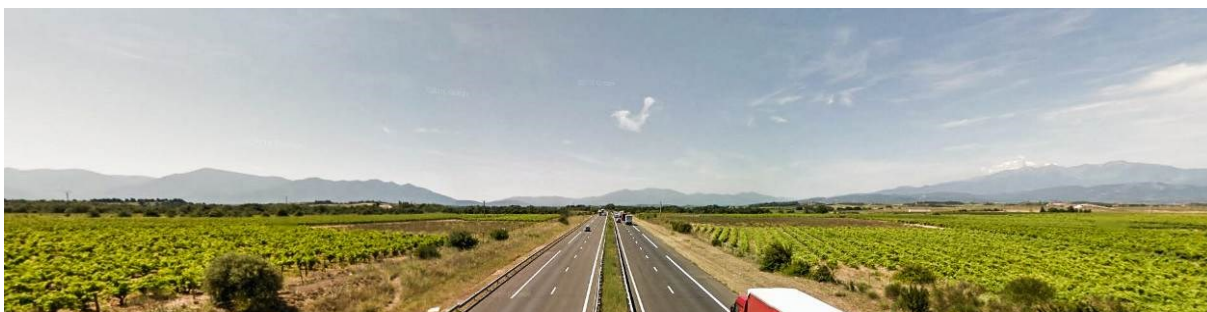
Autoroute 9 La Catalane traversant les Aspres viticoles et donnant à voir les massifs des Albères et des Aspres
