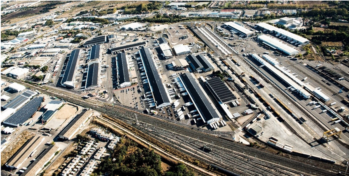
Le Marché International Saint-Charles, Perpignan et ses dispositifs solaires sur toiture.
