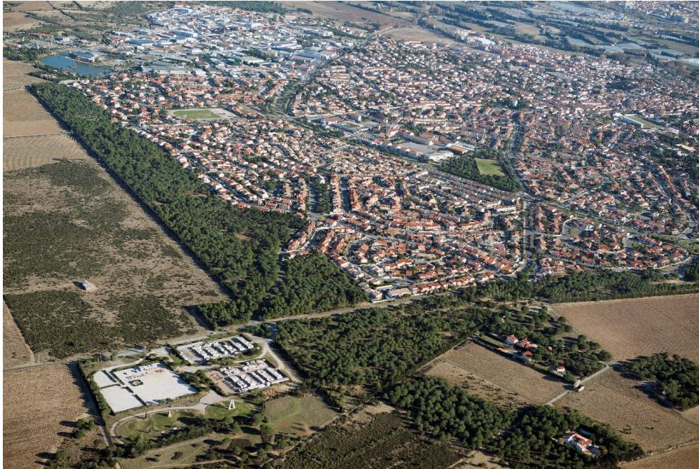
Figure 90 : La forêt communale de la Pinède à Saint-Estève et son étang à l'Est - Source : AURCA
