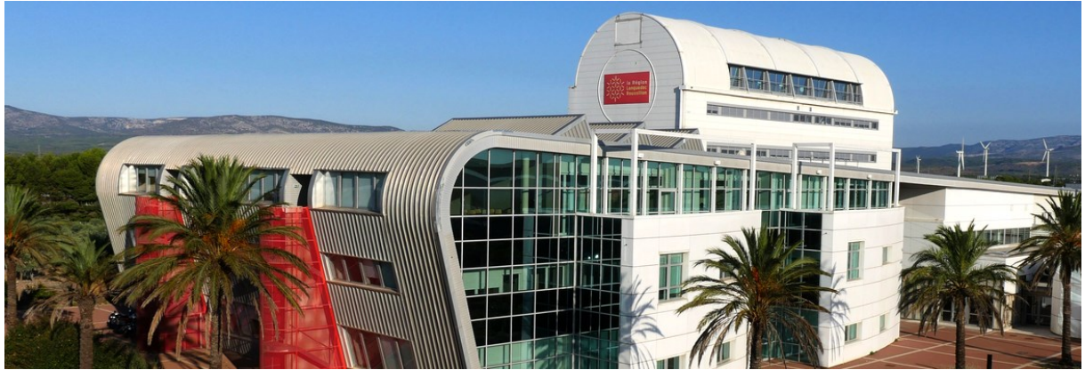
Figure 86 : Le Campus de Formation des Métiers de l'Artisanat, CFMA, à Rivesaltes - Source : CMA des P-O.
