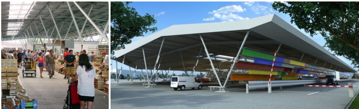
Figure 67 : La Halle aux carreaux de Perpignan - Source : Marché de gros et Le Journal Catalan.
