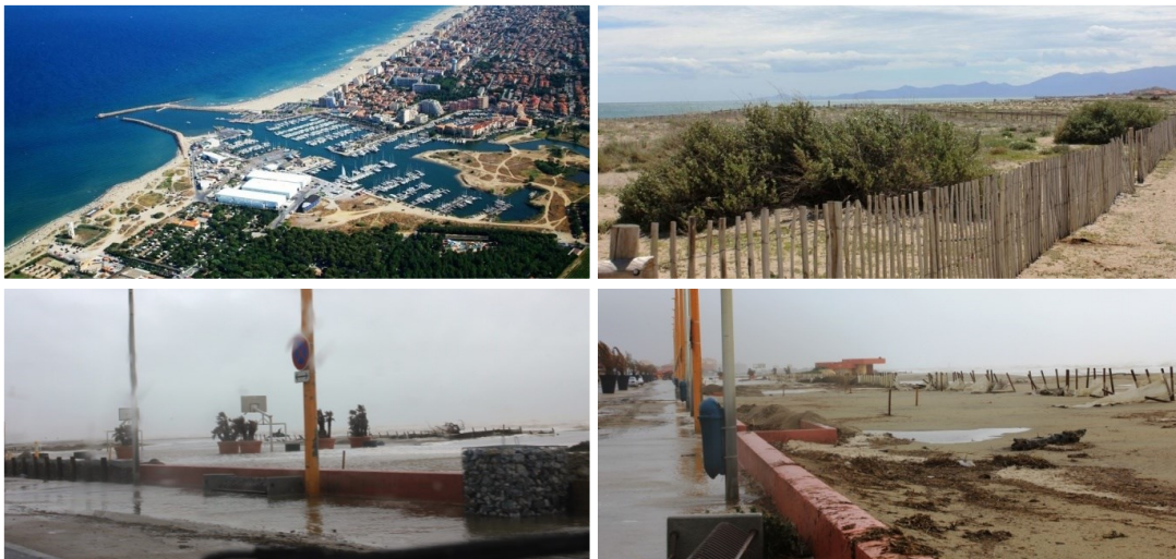
Digues portuaires à Canet (en haut à gauche), ganivelles au Barcarès (en haut à droite) et épisode de submersion au Barcarès lors de la tempête de mars 2013 (en bas).
