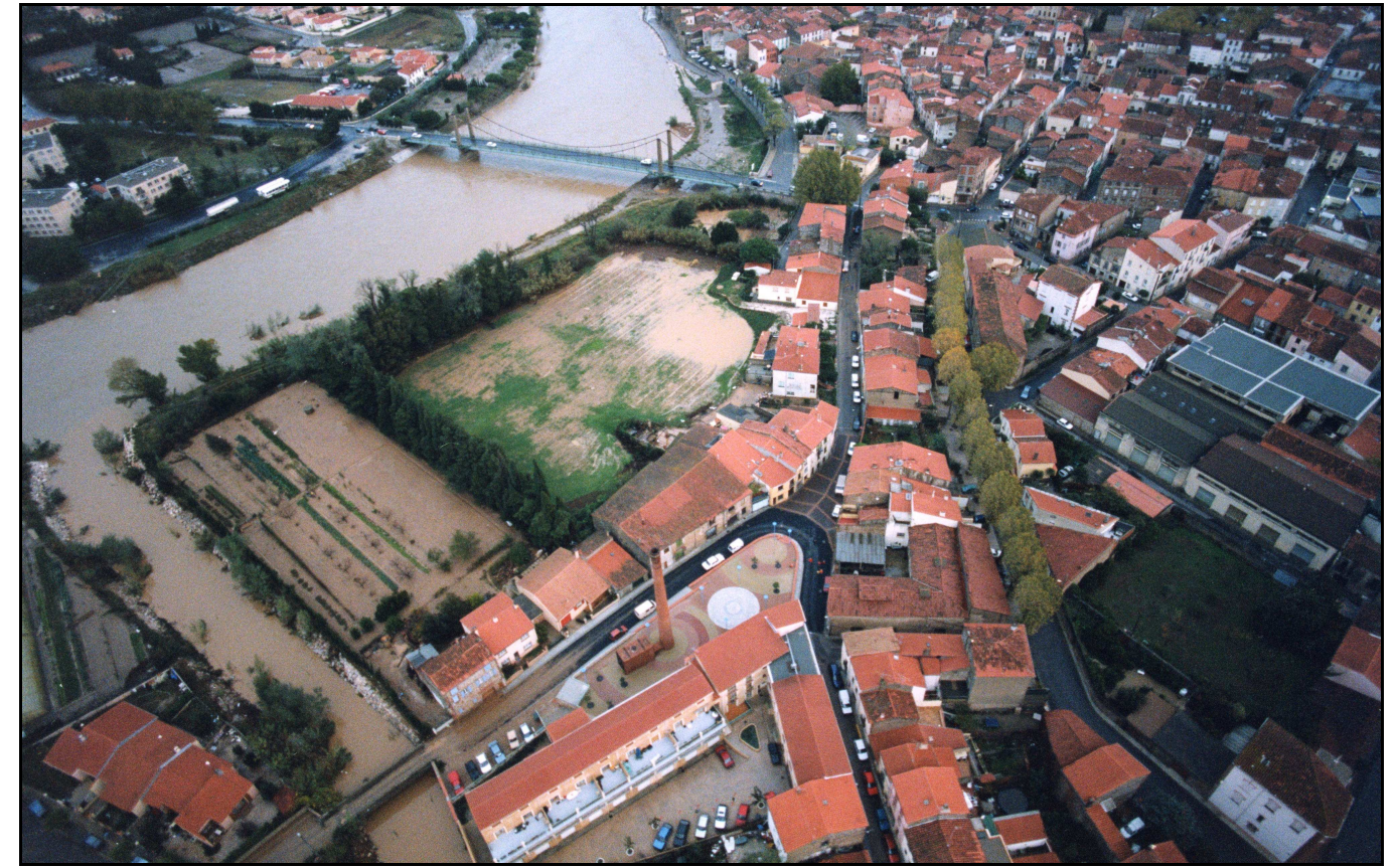
Le centre historique après la crue de novembre 1999
