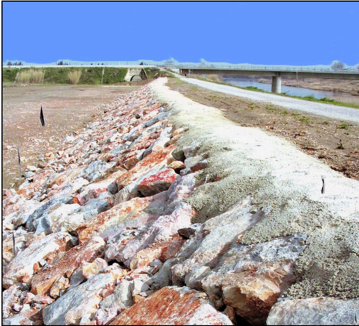
Enrochements posés sur la face aval des digues après la crue novembre 1999
