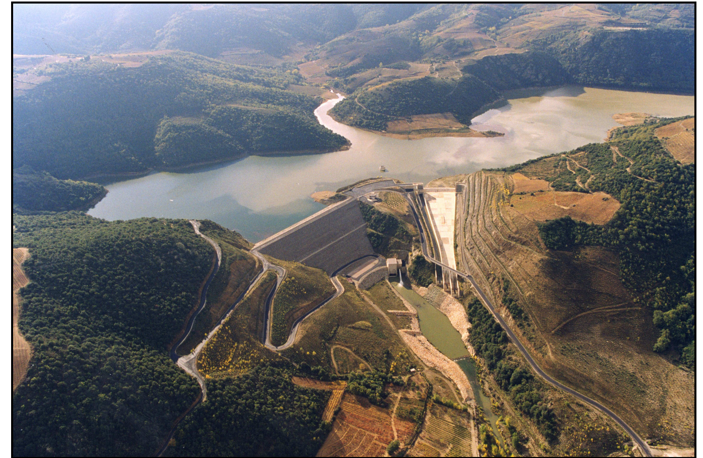
Vue du barrage sur l'Agly après la crue de novembre 1999
